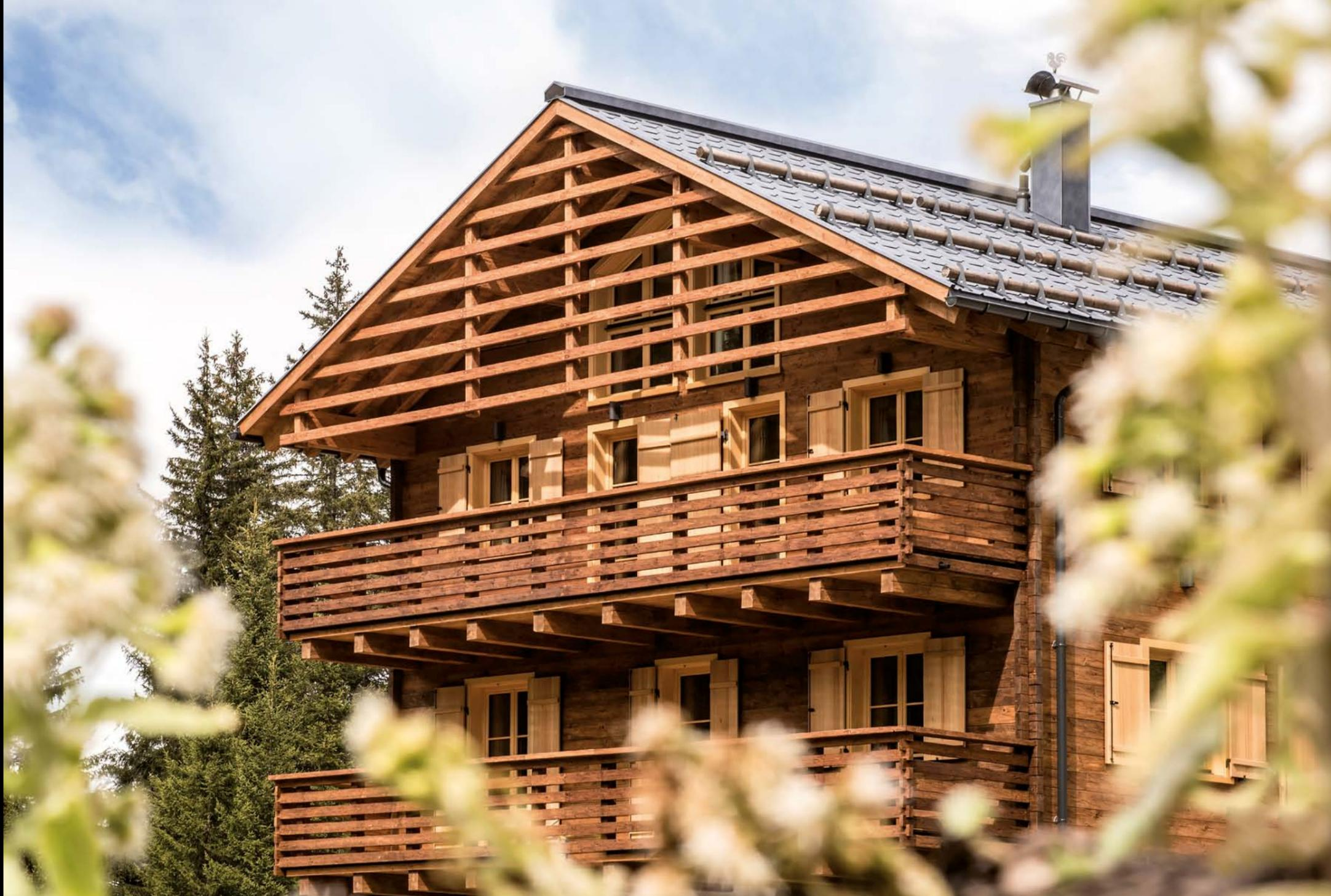
Retro-Timber ist eine Rustik-Schalung aus 40mm starker, gedämpfter Fichte. Brettlängen bis 5m sind lieferbar. Die Oberfläche ist einseitig gehackt und gebürstet und vermittelt so einen raubeinigen Charme, der perfekt in das alpine Ambiente passt. Bei dem Projekt wurde auch Bauholz in gleicher Oberflächenoptik verbaut.
