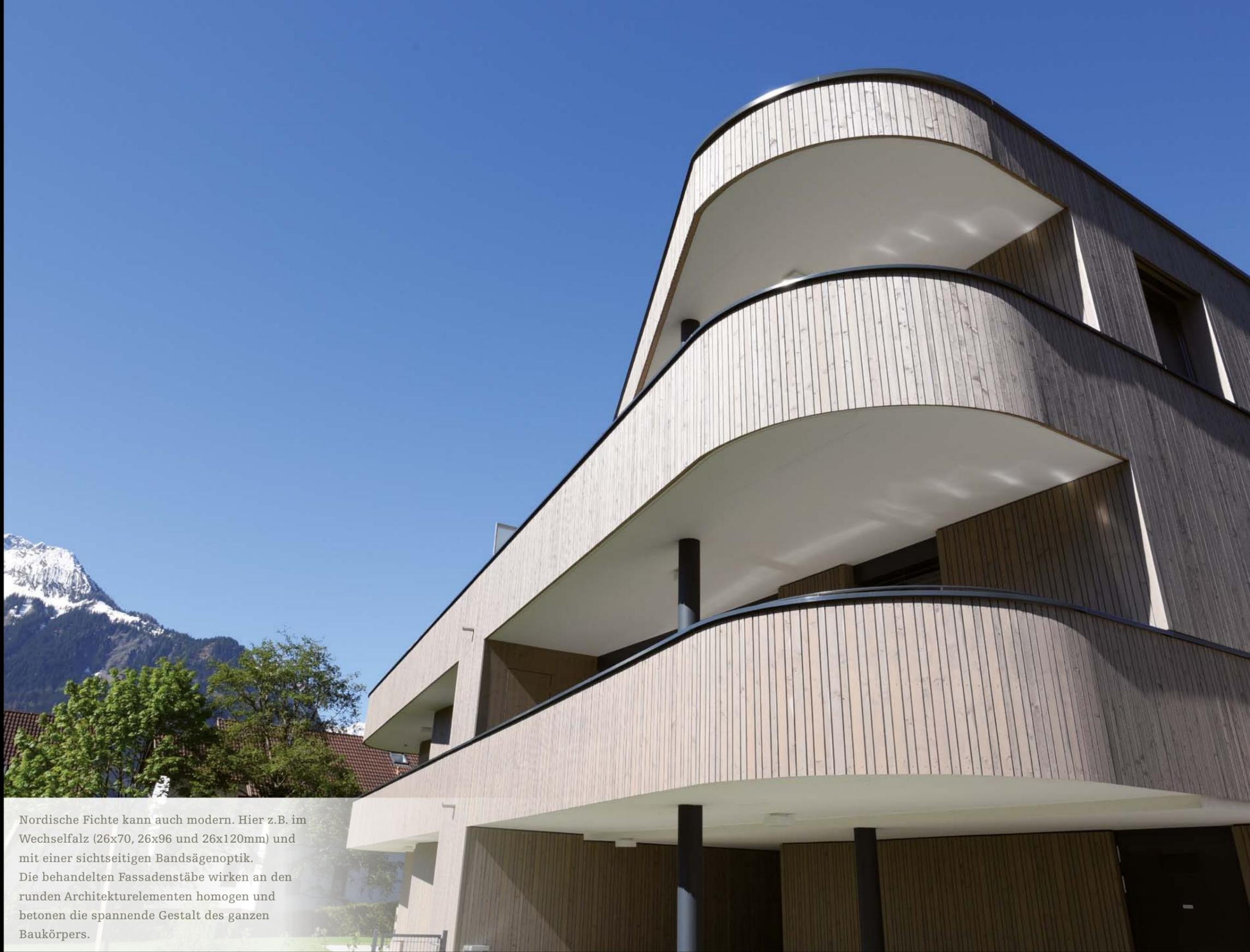
Nordische Fichte kann auch modern. Hier z.B. im Wechselfalz (26x70, 26x96 und 26x120mm) und mit einer sichtseitigen Bandsägenoptik. Die behandelte Fassadenstäbe wirken an den runden Architekturelementen homogen und betonen die spannende Gestalt des ganzen Baukörpers.
