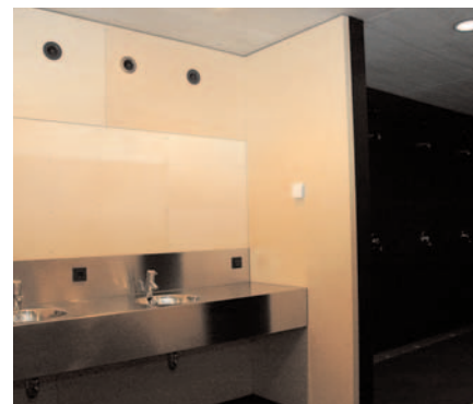
Für die Nassräume wurden hochwertige VISUVESI-Birkenholzsperrholzplatten verwendet – das gleiche Grundmaterial wie bei SONODRILL®.
